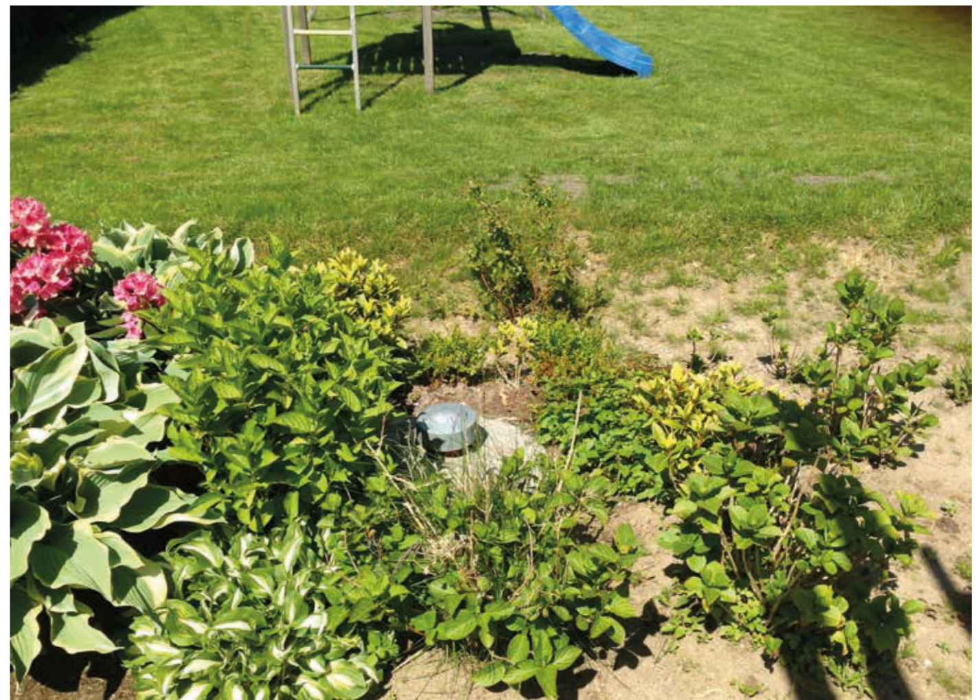
Overløb fra faskine til regnbed i baghave
